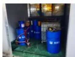
建立固废区，固废库改造
