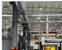
焊接车间除尘管道全套改善更换
